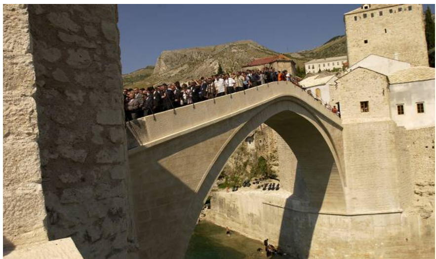
1. Bosnie-Herzégovine. Mostar. Le pont reconstruit après le canonnage de 1993.
